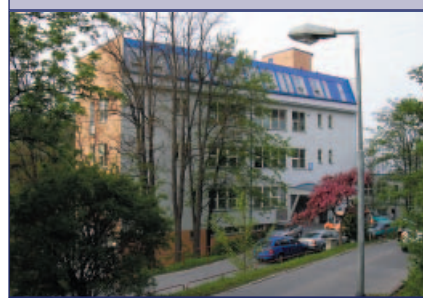
...a po rekonstrukci
